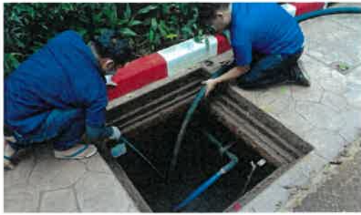
ภาพที่ 2.2-7 สูบตะกอนระบบบำบัดน้ำเสีย
