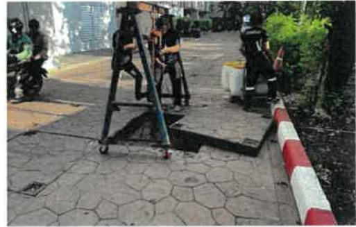
ภาพที่ 2.2-7 สูบตะกอนระบบบำบัดน้ำเสีย
