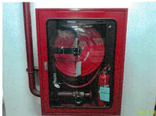
ตู้เก็บสายฉีดน้ำดับเพลิงพร้อมอุปกรณ์ (FHC)
